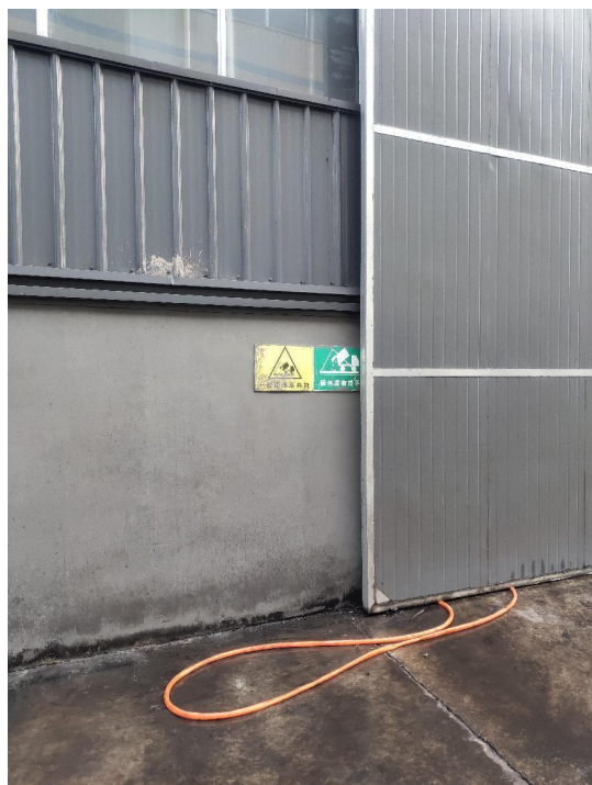
一般固废库（煤场西部）
